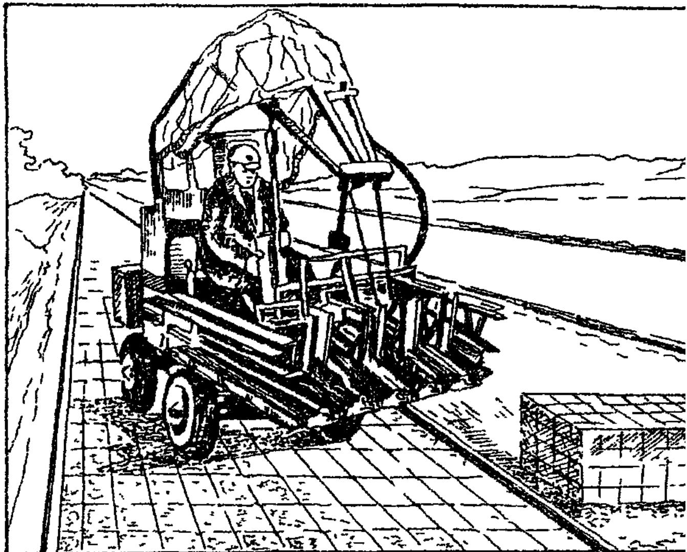
Рис. 3.5. Укладка плит при помощи плитоукладчика
